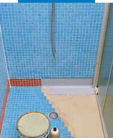
Izolovanie proti vode a lepenie obkladových prvkov v prefabrikovanom sprchovacom kúte
