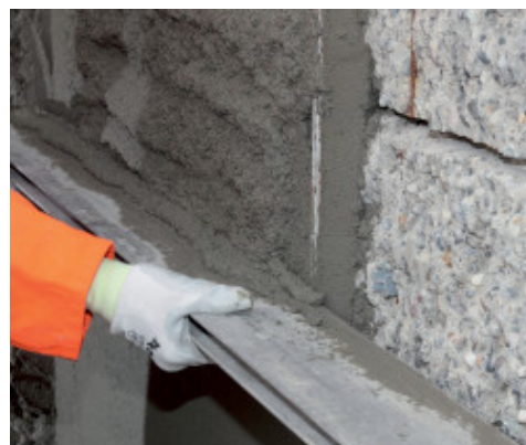
Vyrovnanie Mapegrout 430 s použitím laty
