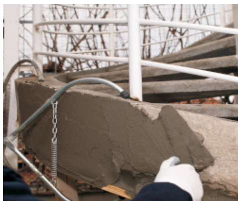
Aplikácia Mapegrout 430 s murárskou lyžicou
