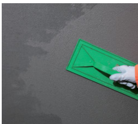
Konečné vyhladenie Mapegrout 430
