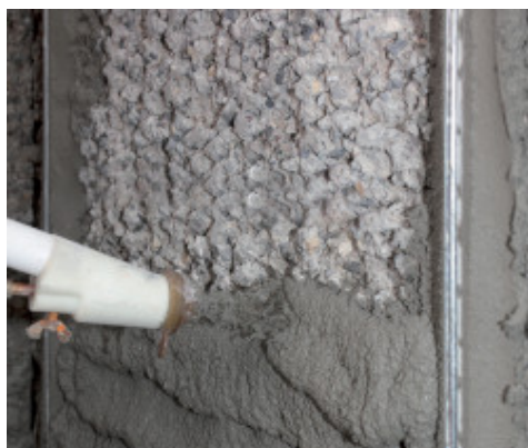
Aplikácia Mapegrout 430 striekacím zariadením
