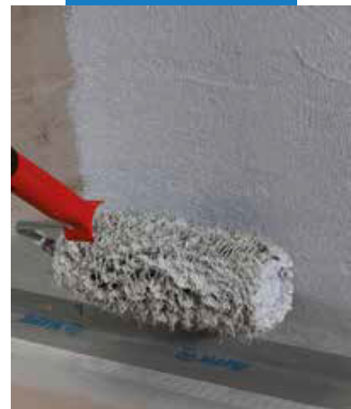
Inštalácia veľkoformátovej dlažby
