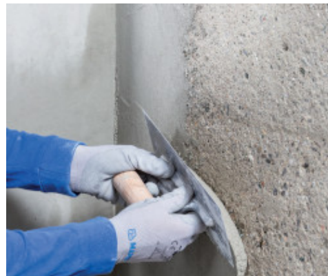
Aplikace Planitopu Rasa & Ripara R4 hladítkem
