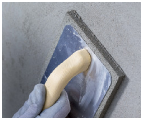
Vyhlazení povrchu Planitopu Rasa & Ripara R4 houbovým hladítkem
