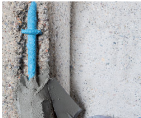
Aplikace Planitopu Rasa & Ripara R4 zednickou lžící
