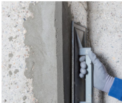
Vyhlazení povrchu Planitopu Rasa & Ripara R4 hladítkem
