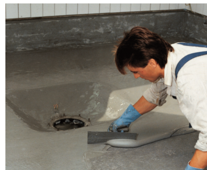
Použitie PCI Apoflex F na izoláciu podláh pod keramickú dlažbu veľkochyne.
