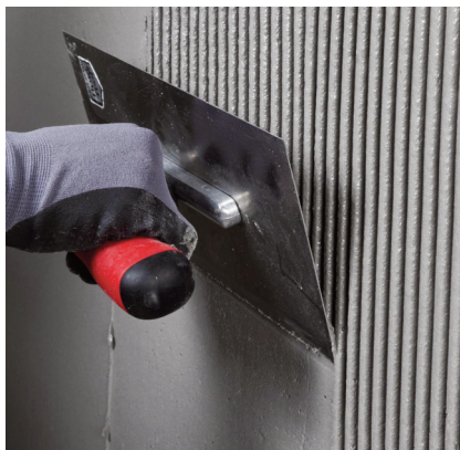
Po vyhladení poslednej vrstvy nanesej ozubeným hladidlom vznikne rovný, jemne štruktúrovaný povrch.
