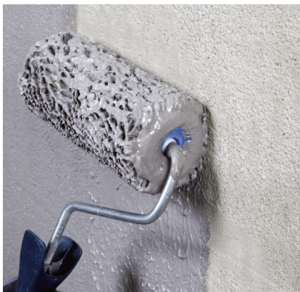
Nanesenie kontaktnej vrstvy valčekom.
