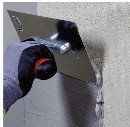
Kontaktná vrstva sa môže naniesť aj hladidlom vo forme penetračnej stierky.
