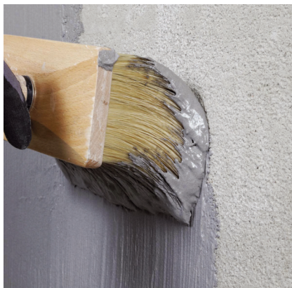
Nanesenie kontaktnej vrstvy štetkou alebo štetcom.
