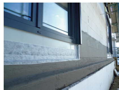
Pripojenie okna pri prechode k hydroizolácii sokla s PCI Barraseal Turbo
