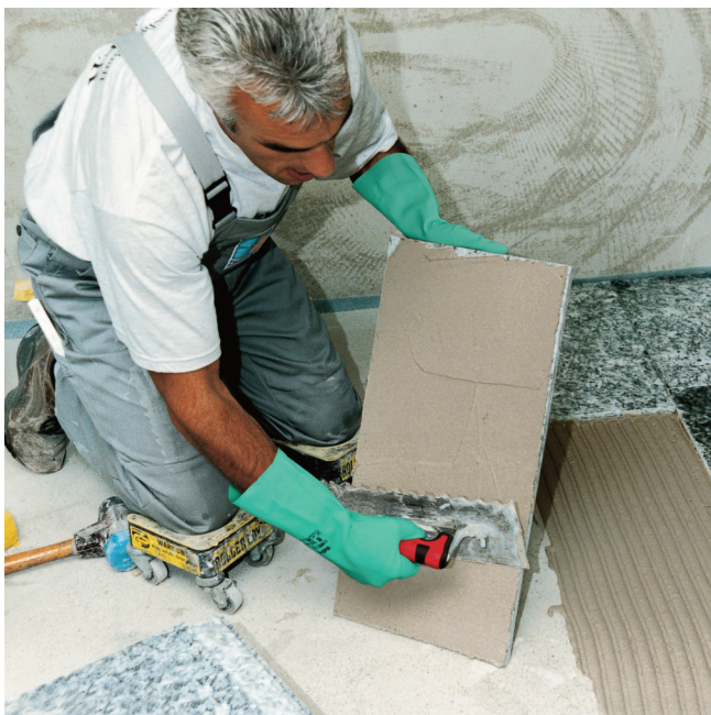
Pri bezdutinovej pokládke je potrebné naniesť maltu aj na rubovú stranu dlažby.
