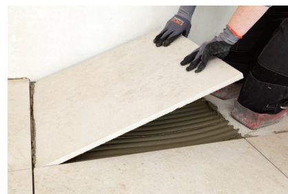
S PCI Carrament ® grau je možná bezpečná pokládka prírodného kameňa metódou strednovrstvového lepiaceho lôžka.
