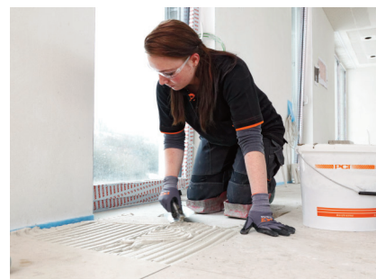
S PCI Carrament ® weiß je možná bezpečná pokládka prírodného kameňa metódou strednovrstvového lepiaceho lôžka.
