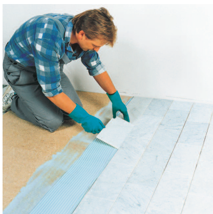
S lepidlom na keramické obklady a dlažby na báze reaktívnych živíc PCI Collastic® je možné lepiť aj mramor na drevotrieskové dosky.
