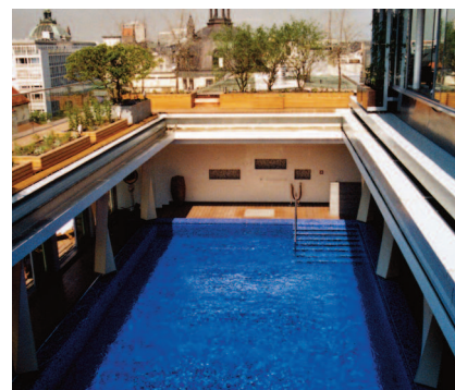
Obklad bazéna s PCI Collastic®.
