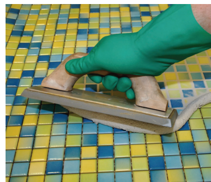
Škárky vyplnené s PCI Durapox ® NT a PCI Durapox ® NT plus sú chemicky odolné a vodonepriepustné.
