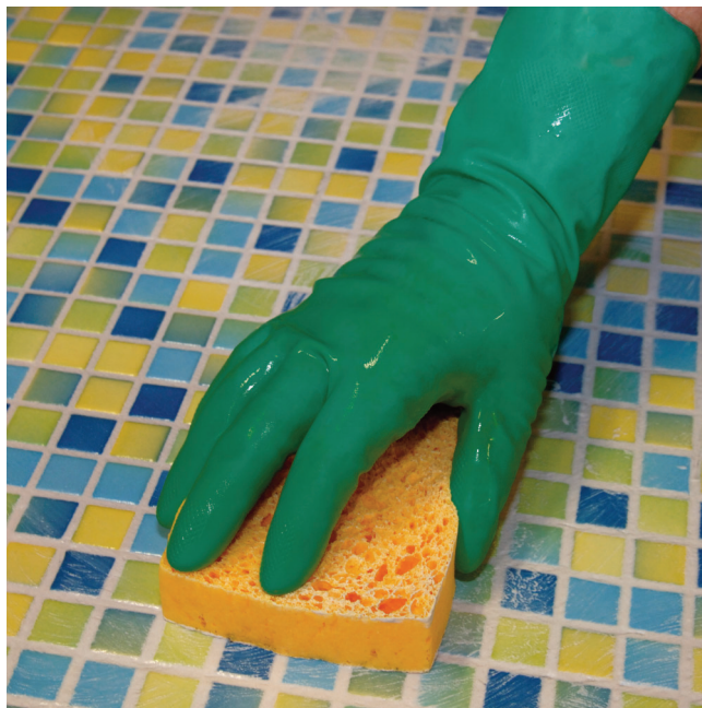
Čistenie vyskárovanej plochy s PCI Epoxi-Schwamm fein.
