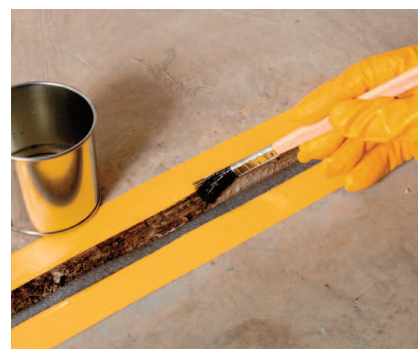
PCI Elastoprimer zlepšuje prílnavosť PCI tesniacich hmôt na dané podklady (viď. tabuľka penetrácií str. 4 a 5).
