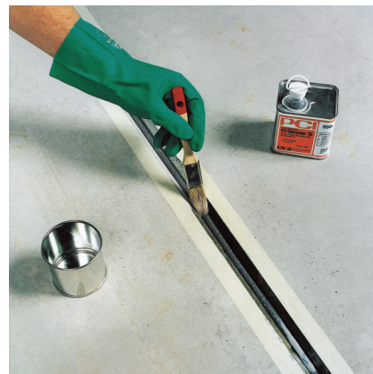
Pred škárovaním napenetrovať štetcom vyčistené boky škár s PCI Elastoprimer 110 až do nasýtenia. Po odvetraní min. 50 minút a max. 2 hodiny ...
