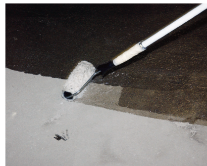
PCI Epoxigrund 390 sa aplikuje na pripravený povrch štetkou alebo valčekom
