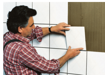
Spôľahlivé lepenie obkladu do tenkovrstvového lepiaceho lôžka s PCI FT ® Klebemörtel
