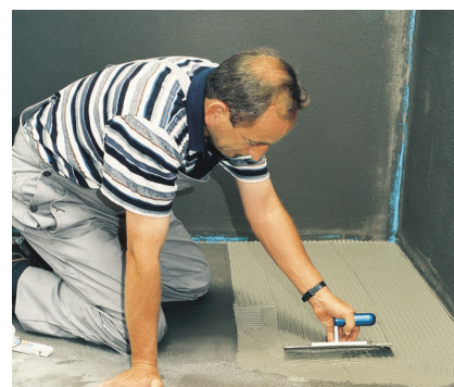
Tenkovrstvové a strednovrstvové lepiace lôžko s prísadou PCI Lastoflex znižuje pnutie v podklade a vyrovnáva napätie spôsobené kolísaním teplôt.
