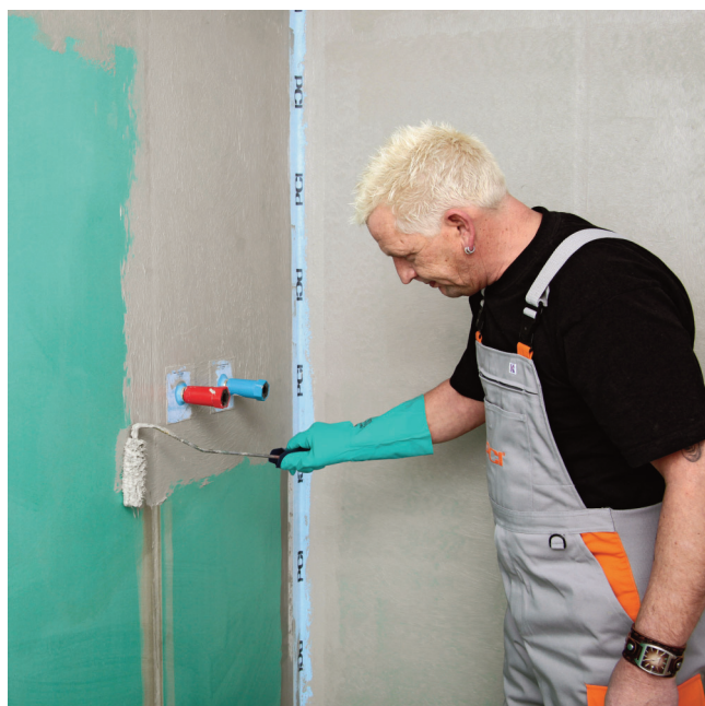
4. Prvú vrstvu PCI Lastogum® (grau) neriedený naniesť celoplošne a sýťo na podklad.
