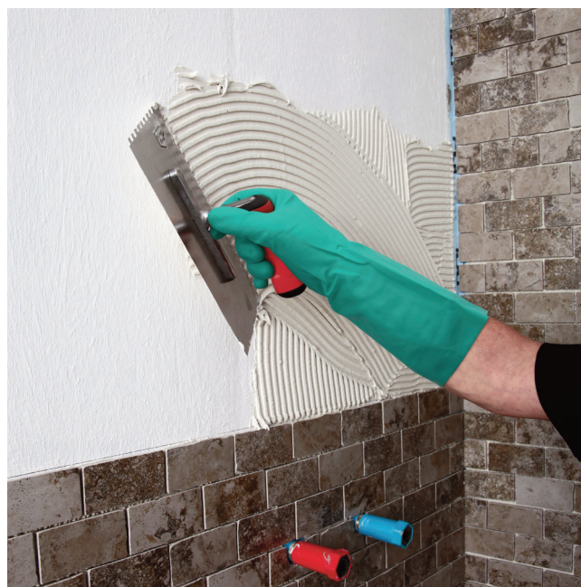
6. Po vytvrdnutí izolačnej vrstvy PCI Lastogum® je možné začať s pokládkou obkladu.
