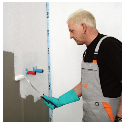
PCI Lastogum sa nanáša neriedený valčekom, štetkou alebo hladidlom na pripravený podklad.
