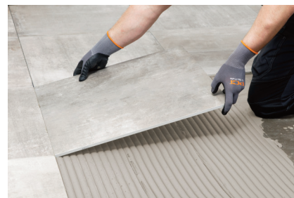
PCI Nanorapid má dlhú dobu spracovateľnosti v kombinácii s presnou a rýchlou dobou tuhnutia.
