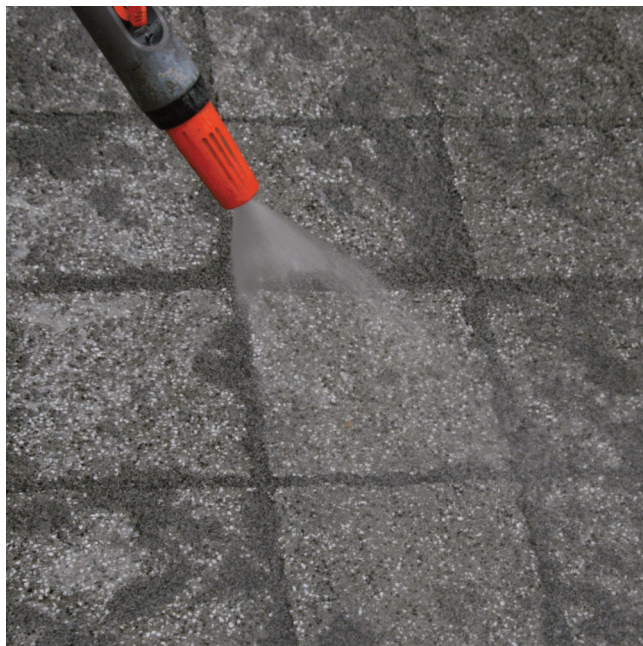
Pri škárach so šírkou od 3 do 8 mm podporiť úplné vyplnenie škáry prúdom vody. Pri veľmi úzkych škárach viesť prúd vody pozdĺž škár. Prepadnuté škáry ihneď doplniť čerstvým materiálom.
