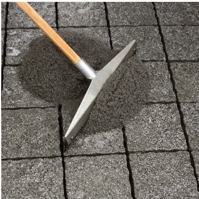
Škárovaciu maltu gumenou stierkou zatlačiť do škár.
