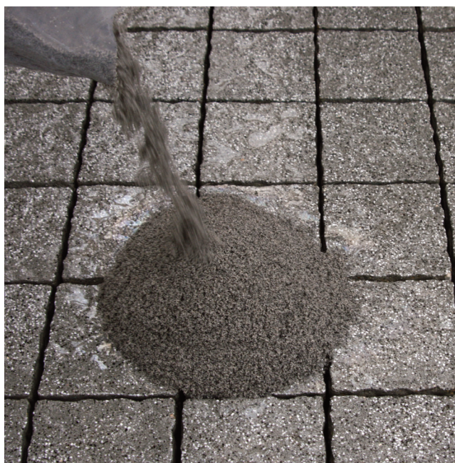
Vákuové vrečko PCI Pavifix 1K Extra nastrihnúť a čerstvý materiál nasypať na vlhký povrch.
