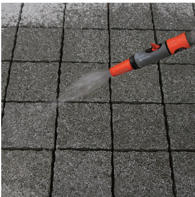
Povrch kociek a boky škár pred škárovaním poriadne navlhčiť.
