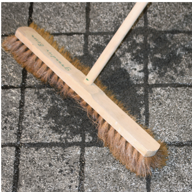
Zvyšky malty úplne odstrániť z povrchu mäkkou metlou.
