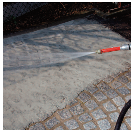
Aby sa pri čistení dlažbových kociek zamedzilo vyplavovaniu hmoty zo škár, je potrebné prúd vody viesť takmer horizontálne na povrch.
