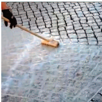
Pri metóde stierkovaním sa PCI Pavifix® CEM ľahko vtláči do škár gumeným hladidlom.
