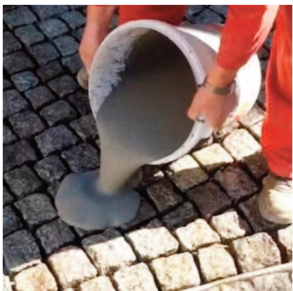
Nanášanie PCI Pavifix® CEM na plochu, ktorá sa má škárať.
