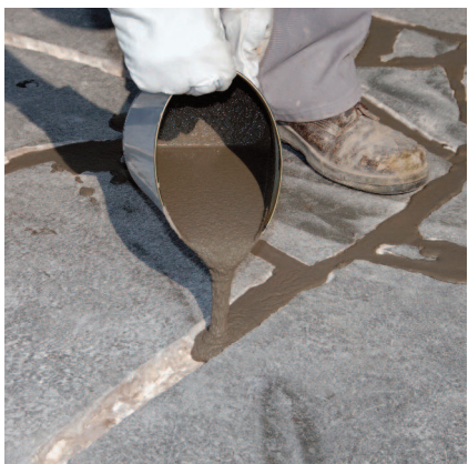
PCI Pavifix® CEM naliať pomocou vhodnej nádoby do pripravených škár.
