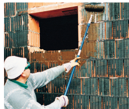
PCI Pecimor® F, riedený vodou v pomere 1 : 5 ako penetračný náter pri hydroizolácii stavieb bitúmenovou stierkou modifikovanou polymérmí podľa DIN 18 195.
