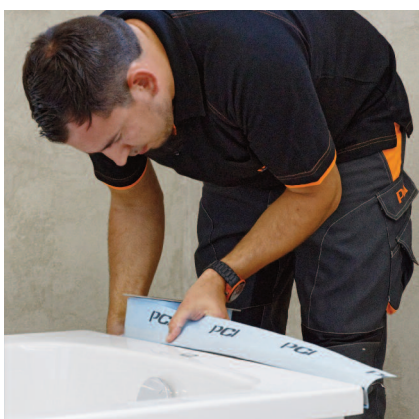
Stiahnuť ochrannú fóliu a PCI Pecitape® WDB nalepiť vrchnou penovou hranou bez prnutia na okraj vane/vaničky.
