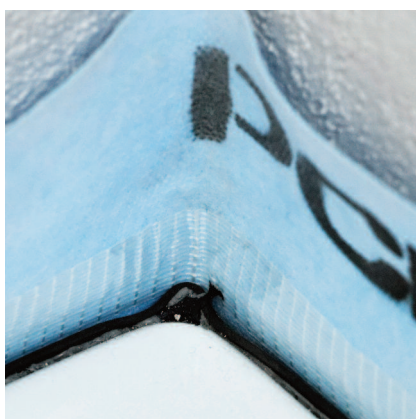
Je dôležité, aby tesniaca páska priliehala v rohu napojenia steny bez prnutia.
