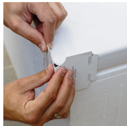
Pomocou šablóny pokrytej voskom vytvoriť pravý uhol.
