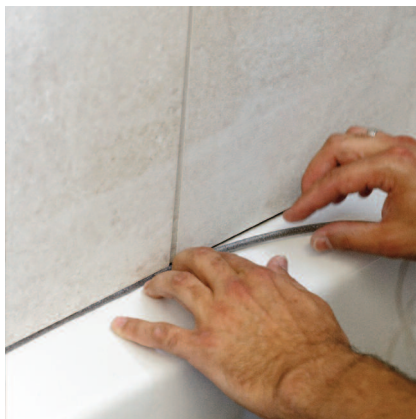
Vložiť tesniaci povrazec a následne aplikovať silikónový tmel.
