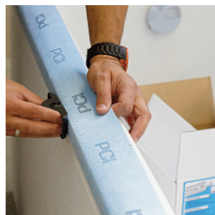
PCI Pecitape® WDB pevne pritlačiť prítlačným valčekom, aby nevznikli žiadne záhyby.
