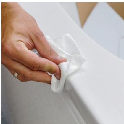
Okraj vane/vaničky dôkladne očistiť čistiacou handričkou a vysušiť suchou handrou.
