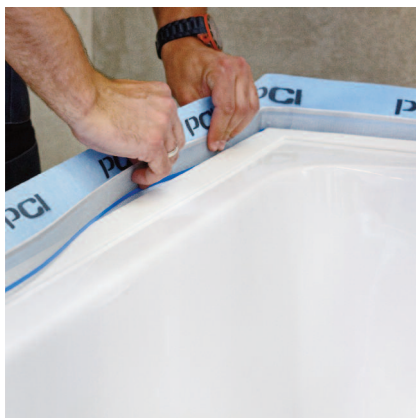
Do predpripraveného vrecka na PCI Pecitape® WDB sa môže vložiť ochranná páska proti prerezaniu PCI Pecitape® Protect.
