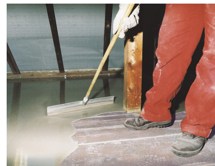
Samonivelizačná hmota PCI Periplan Extra je ideálna pri rekonštrukciách a modernizáciách na vyrovnávanie drevených dosiek a drevotriekových podláh.
