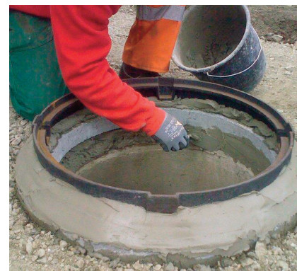
Šachtové poklopy sa dajú rýchlo osadiť s použitím malty PCI Polyfix plus.
