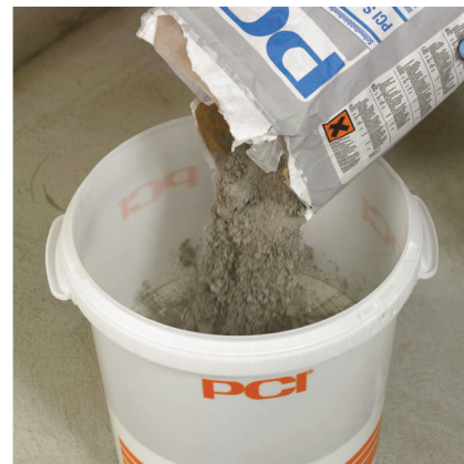
Pridať práškovú zložku PCI Seccoral 2K Rapid.
