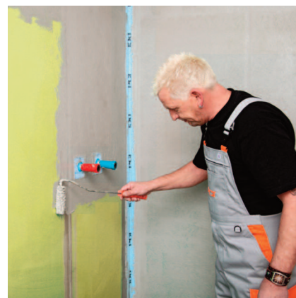
3. Po zaschnutí PCI Wadian® zaizolujte povrch špeciálnou vodotesnou pružnou hydroizoláciou PCI Lastogum®
