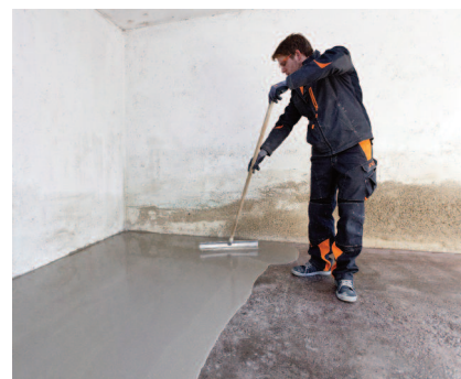
Celoplošné vyrovnávanie podlahy so samonivelizačnou hmotou PCI Zemtec® 1K na priame použitie.
