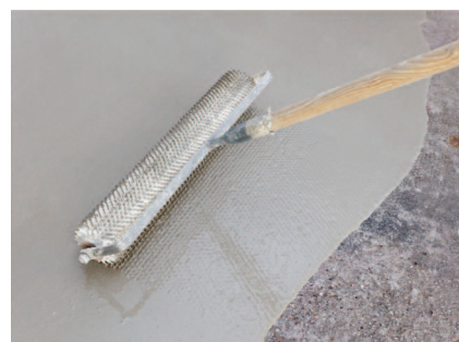
Na nelepivú vytvrdnutú penetráciu vyliat' a rozotrieť PCI Zemtec® 1K a následne vyrovnáť a odvzdušniť ihlovým valčekom.
