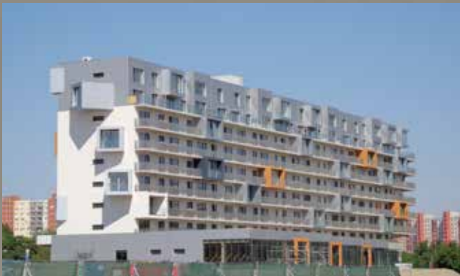
REFERENCIA: Petržalka City, Bratislava Vyrovnávajúci poter Sikafloor® Level-30 s následným farebným epoxidovým náterom Sikafloor®-2530 W
