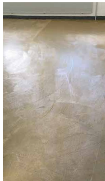
Podklad podlahy pokrytý lepidlom
