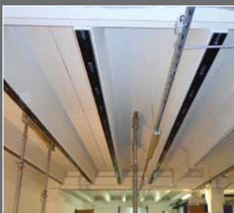
SYSTÉMY NA ZOSILOVANIE NOSNÝCH KONŠTRUKCIÍ
