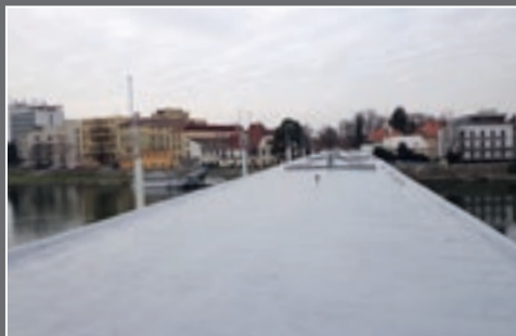
Sikalastic-618 strecha Kolonádový most - Piešťany
